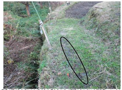
農道(幅はおよそ1.4m)を上から見たところ(楕円のところに木板を敷いていた)
