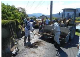
水路の泥上げ
